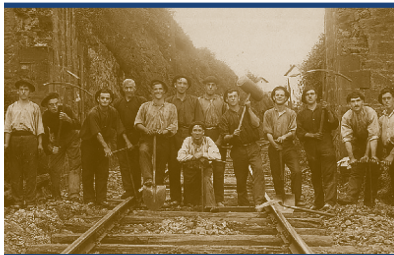
Construyendo la vía férrea
